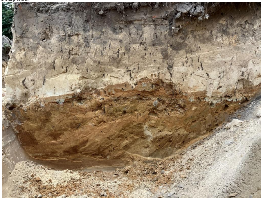
Przekrój przez parter-Wyraźnie widać tło z piasku i wzór z mialu ceglanego z gliną
